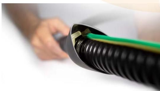
В образовавшуюся воронку всыпать термоглавкий клей и равномерно распределить его в манжете.
